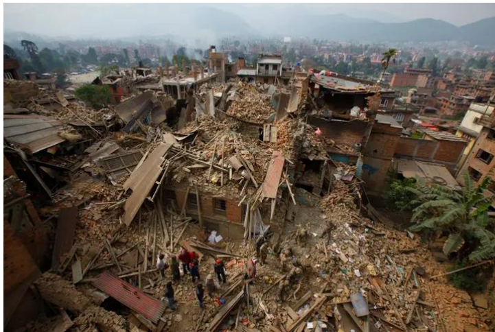
Figura 14-Destruição no Nepal após sismo, 2015
