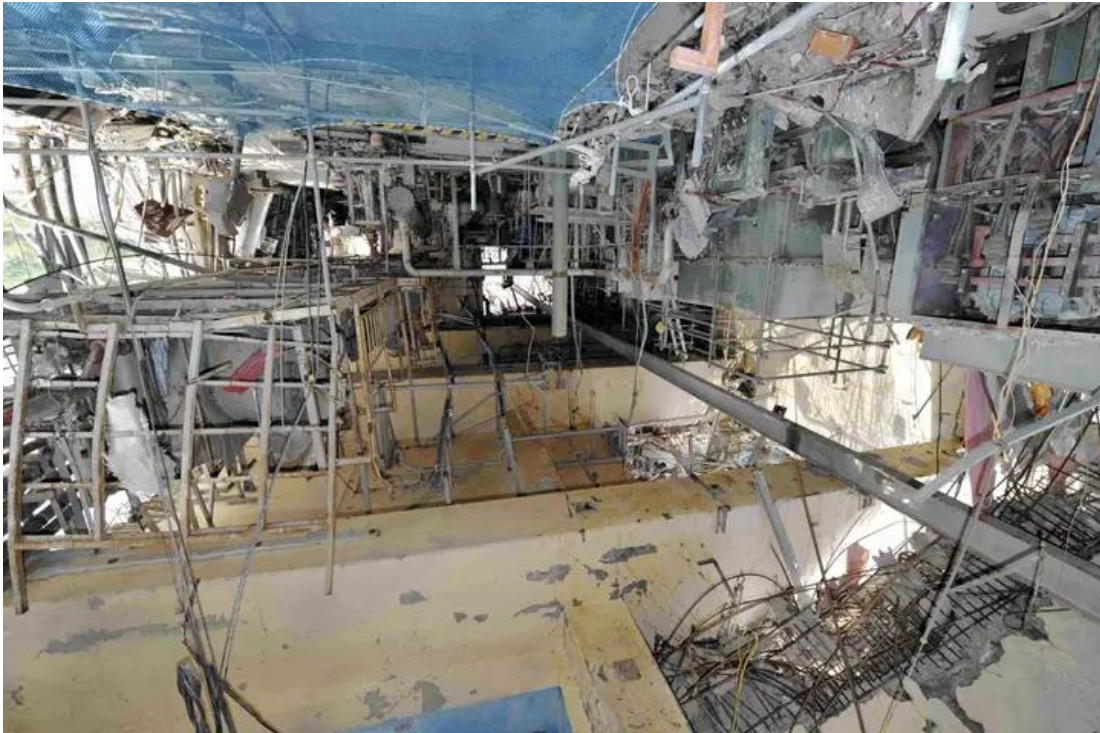
Figura 12-Interior da central nuclear de Fukushima após sismo no Japão, 2011
